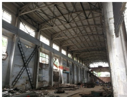
拆除中的天原化工厂
