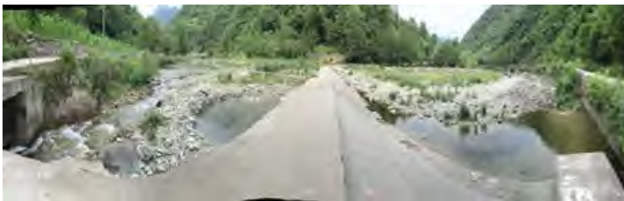
图 5-1 东风堰坝上坝下河段现状
